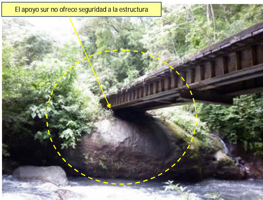
Figura 13. Condición de apoyo de las vigas en los bastiones
