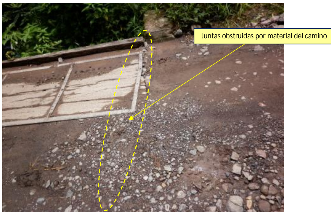
Figura 10. Juntas de expansión del puente
