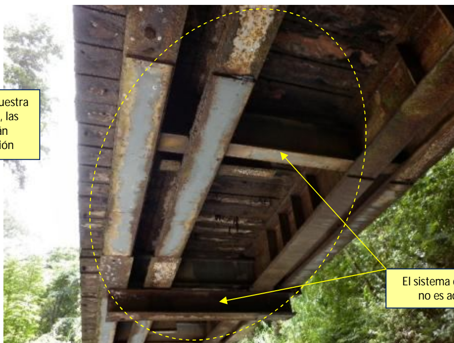
Figura 12. Losa inferior del puente y sistema de apoyo
