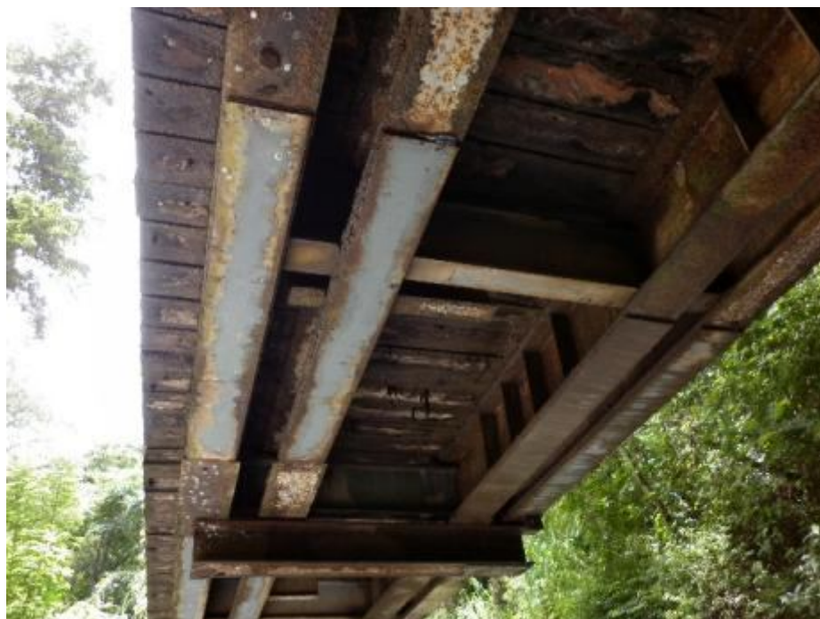
Figura 3. Vista inferior del puente Tizate
