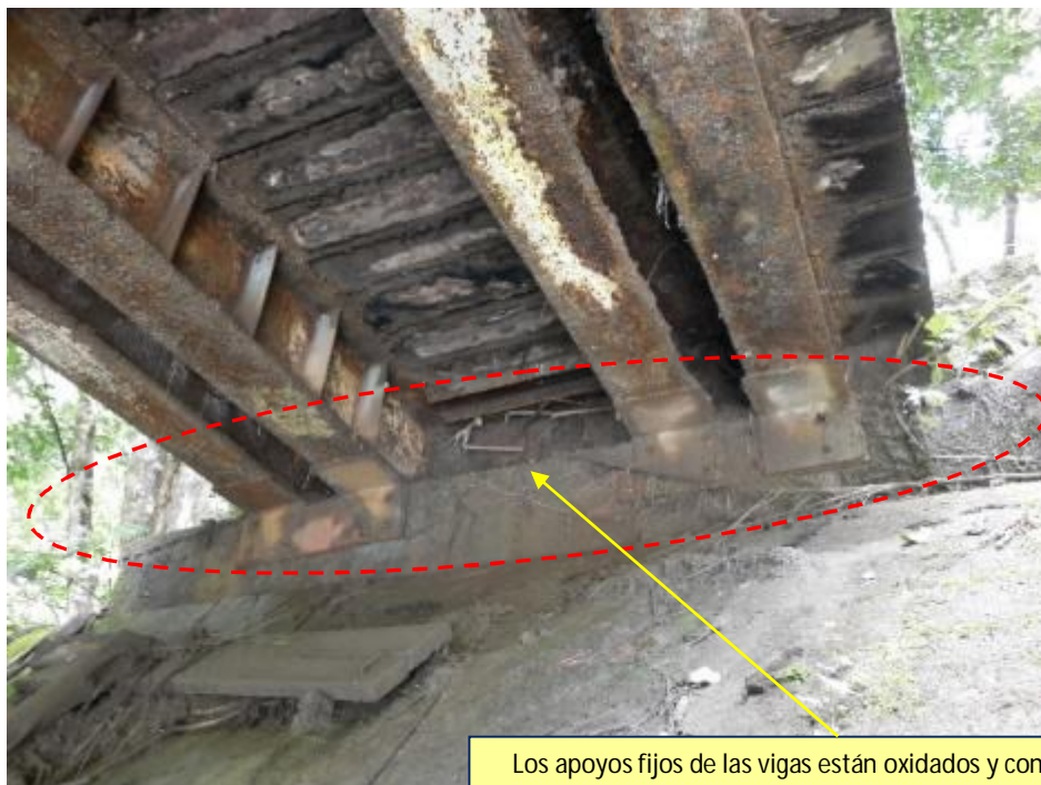
Figura 13. Condición de apoyo de las vigas en los bastiones
