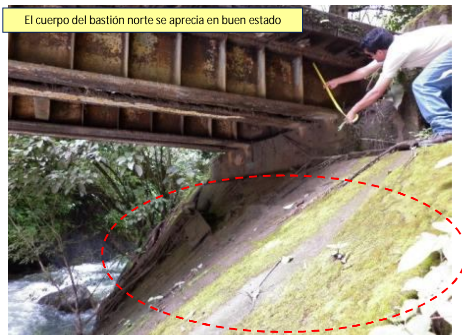
Figura 15. No se aprecia socavación cerca de los bastiones
