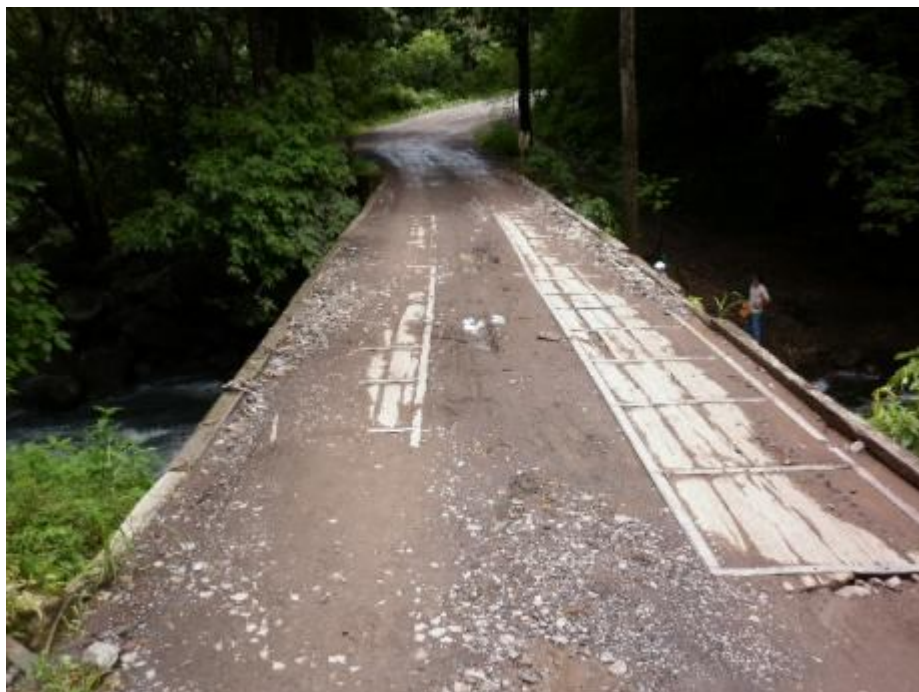
Figura 2. Vista a lo largo del Puente Tizate, Rio Tizate
