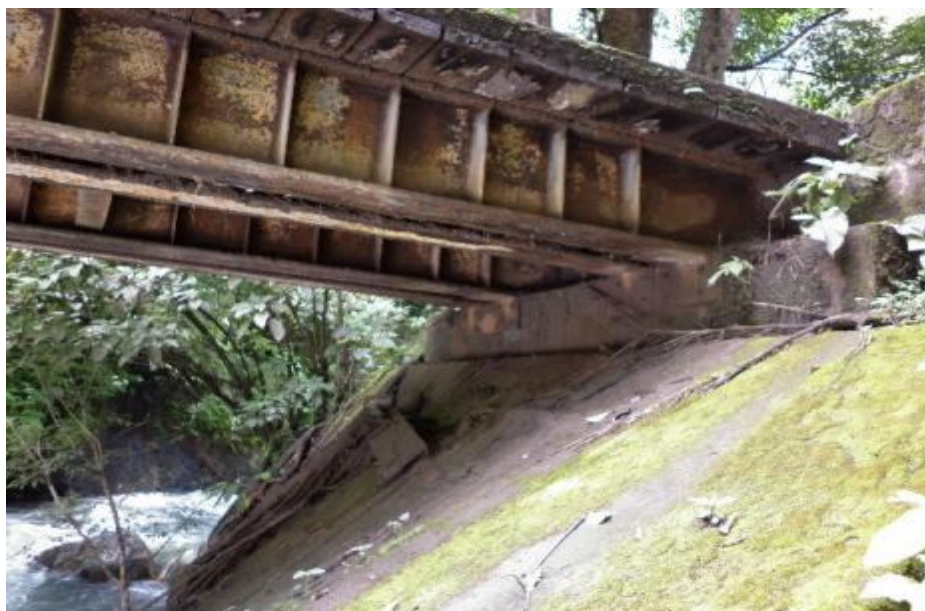
Figura 4. Bastión tipo muro en acceso norte
