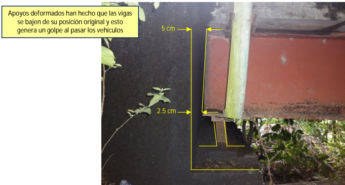
Figura 13. Condición de apoyo de las vigas en los bastiones
