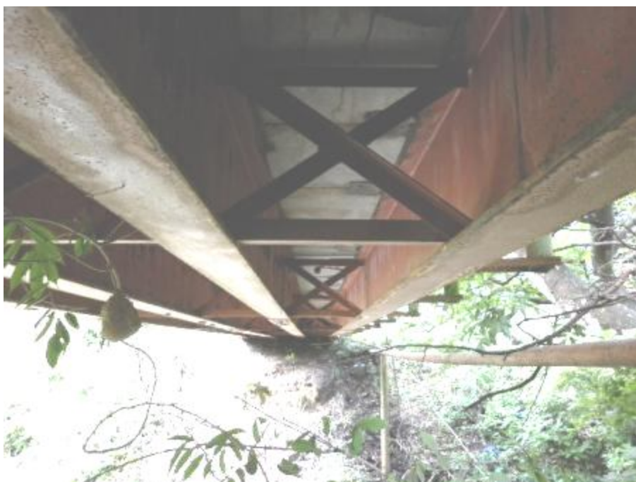
Figura 3. Vista inferior del puente El Guayacán
