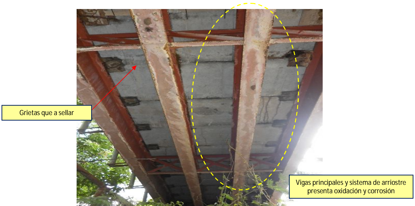
Figura 12. Losa inferior del puente y sistema de apoyo
