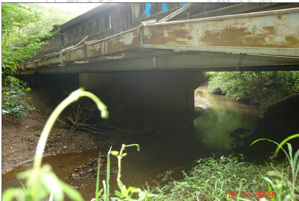
Fotografía 4. Puente sobre el Río Naranjo. Estado del puente al 19 de noviembre de 2009. (LanammeUCR, 2009).
