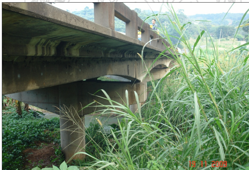
Fotografía 1. Puente sobre el Río Grande. Estado del puente al 19 de noviembre de 2009. (LanammeUCR, 2009).
