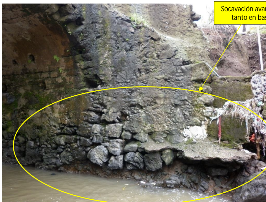
Figura 13. Estado de los bastiones y aletones
