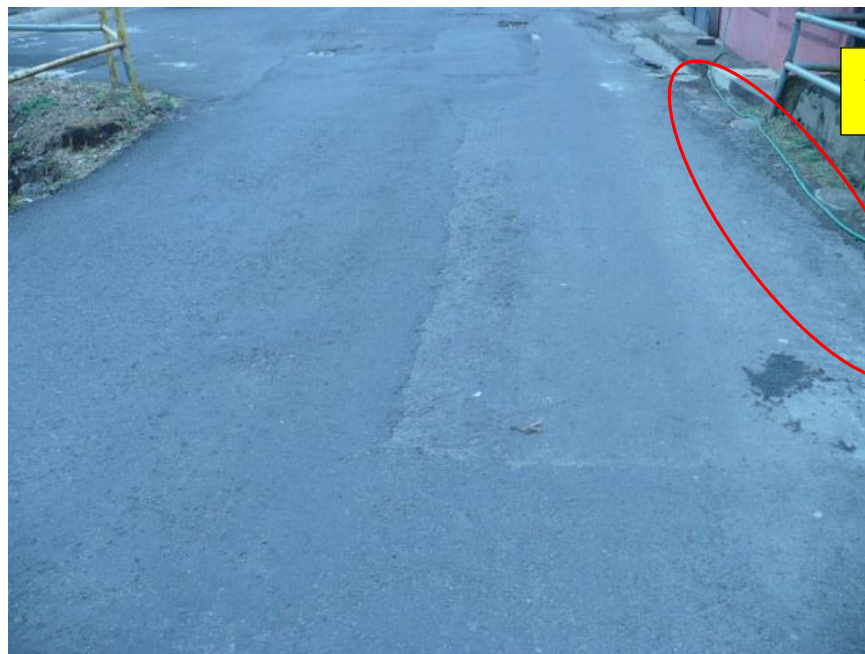
Figura 10. Superficie de ruedo y ausencia de elementos de manejo de aguas superficiales
