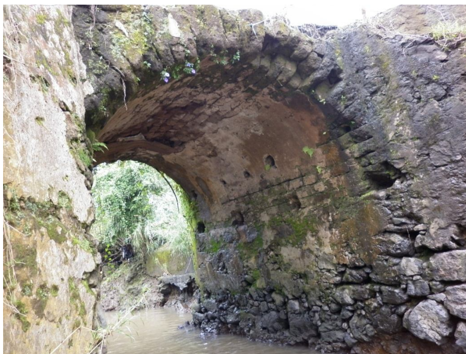
Figura 3. Sistema de arco en mampostería del puente
