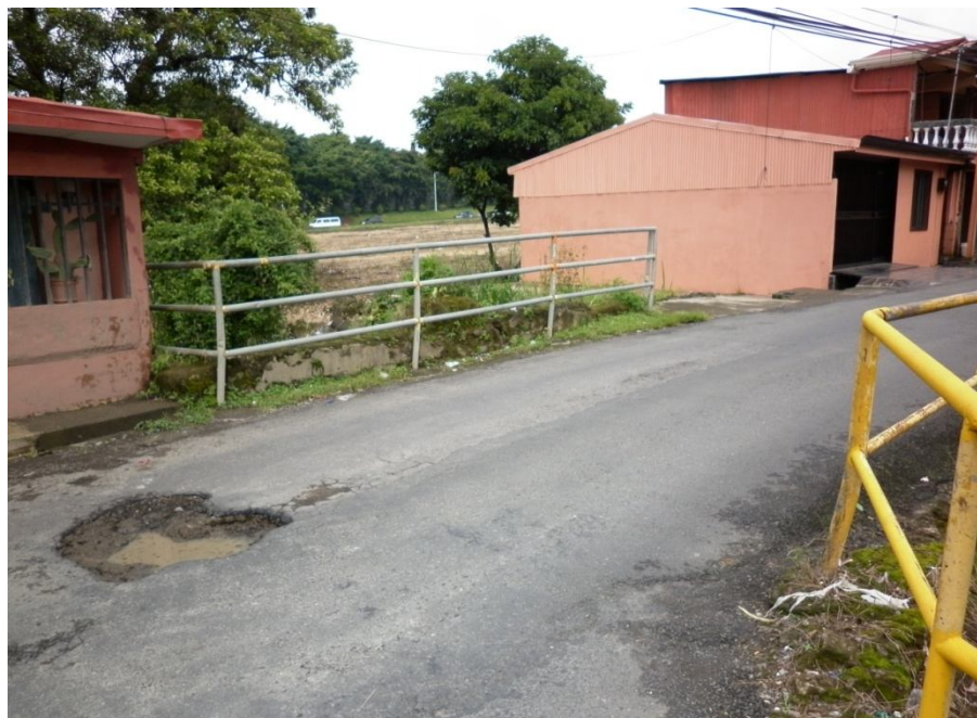
Figura 2. Puente Cristo Rey, Quebrada Seca
