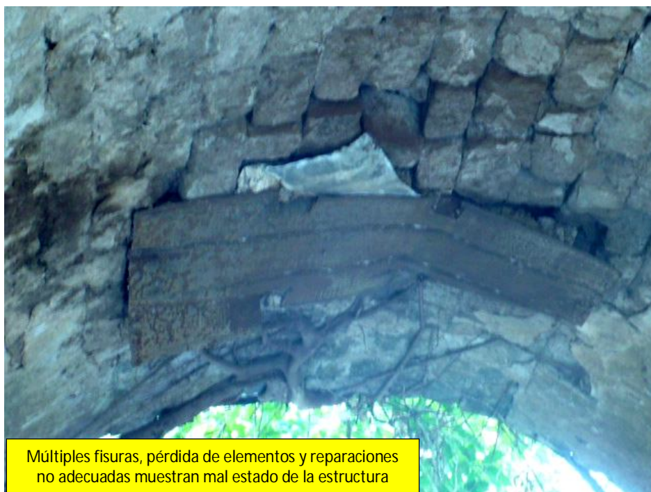
Figura 9. Vista inferior del puente
