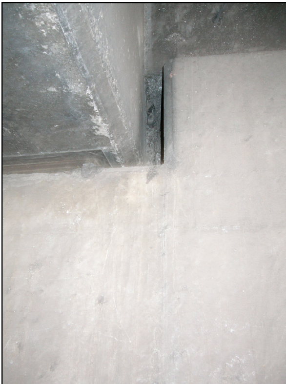
Estado de apoyos
