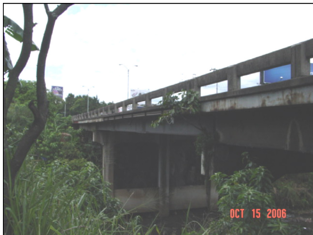
Puente Río Segundo
