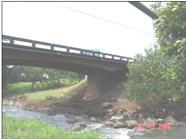
Condición de la subestructura
