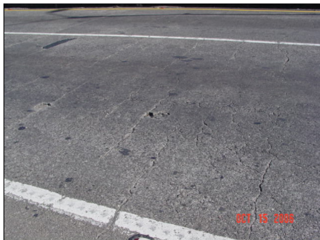
Estado de losa superior
