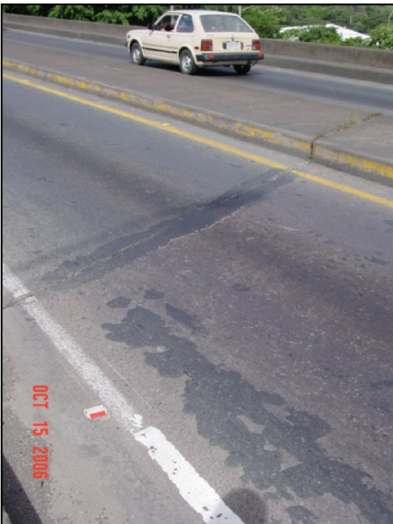
Estado de losa superior
