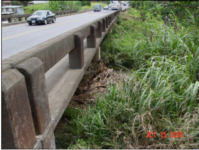
Estado de las barandas
