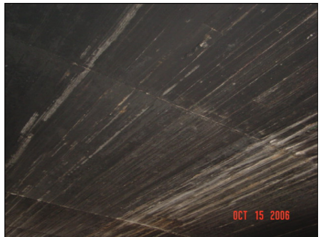
Estado de losa inferior
