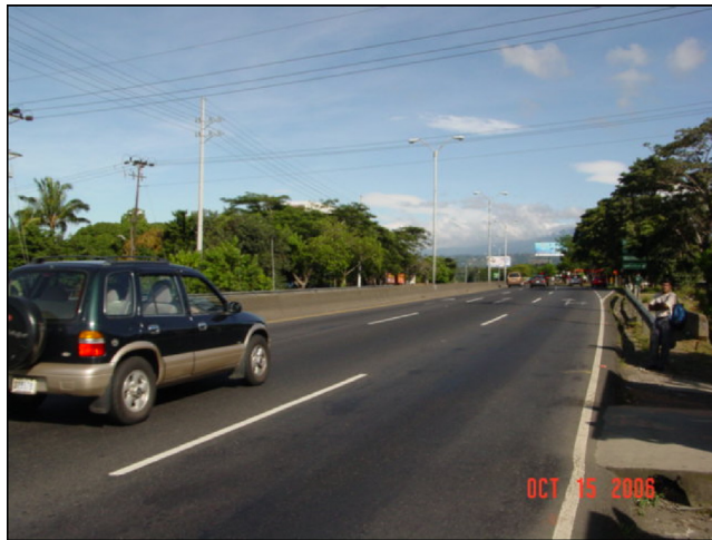
Estado de losa superior
