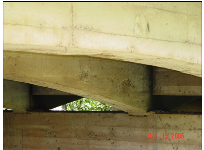
Unión viga - pila
