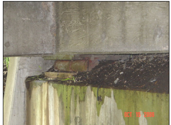
Apoyo de rodillo metálico
