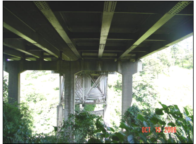
Vigas apoyadas en las pilas
