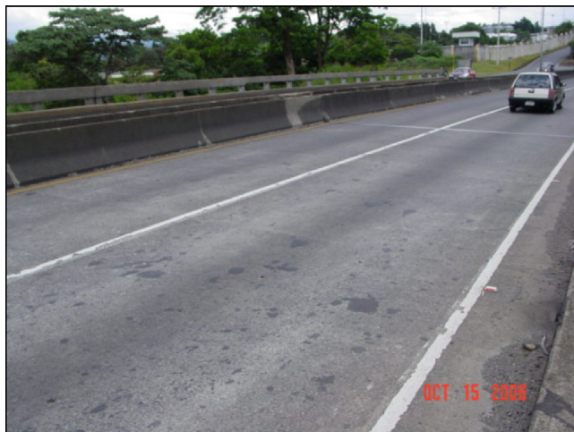
Estado de la losa superior
