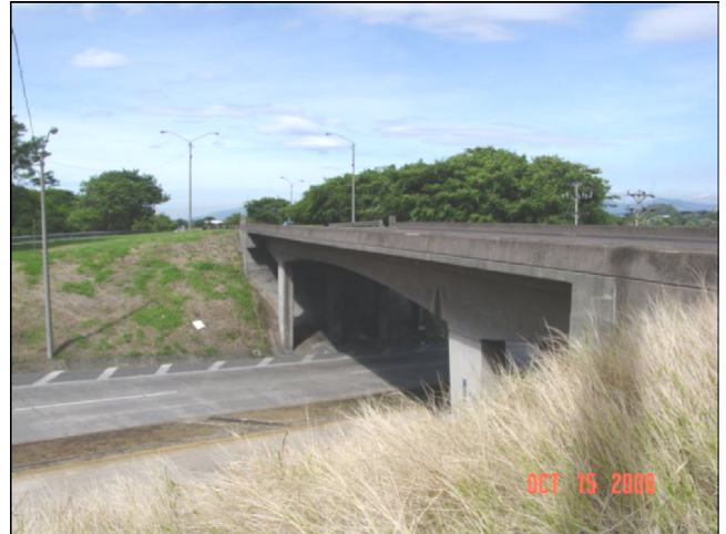
Estado de las barandas
