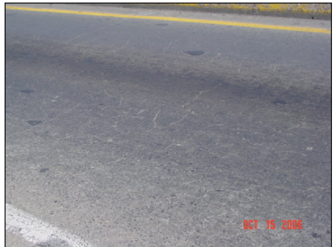
Estado de losa superior
