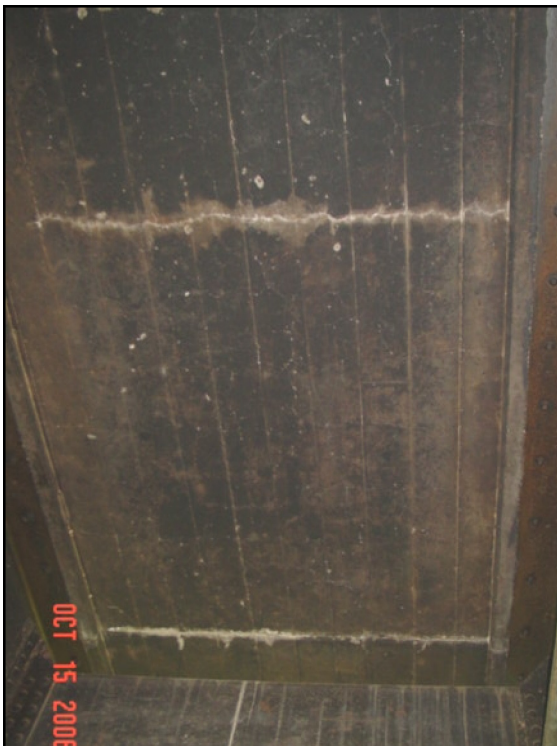
Estado de losa inferior
