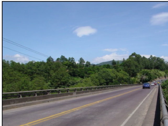
Estado de la losa superior
