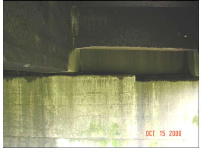
Estado del bastión
