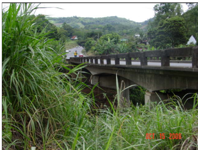
Puente Río Grande 1
