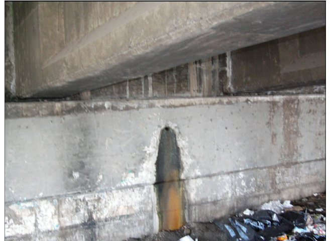
Estado del bastión
