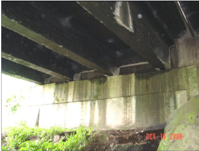
Estado del bastión
