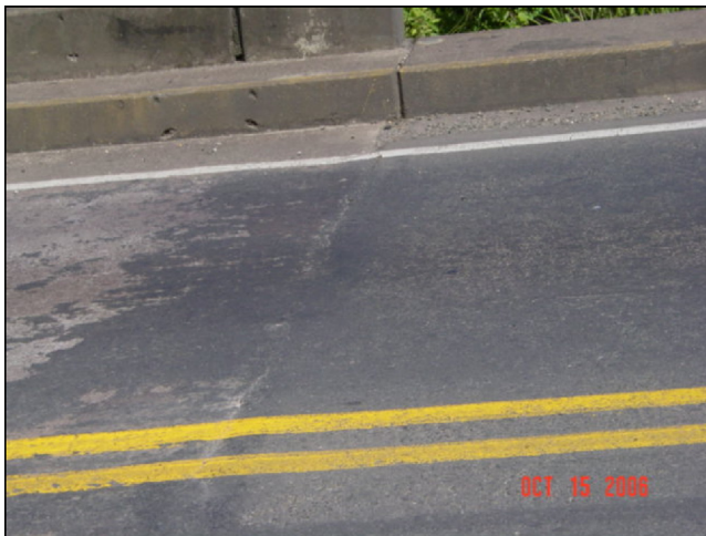
Estado de la losa de aproximación
