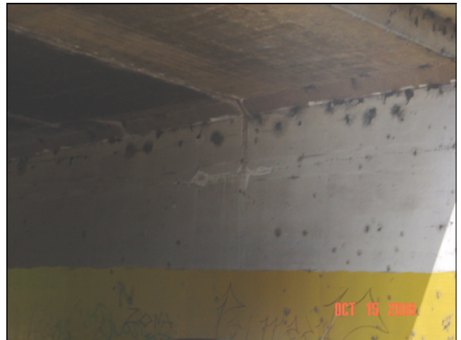
Estado de losa inferior
