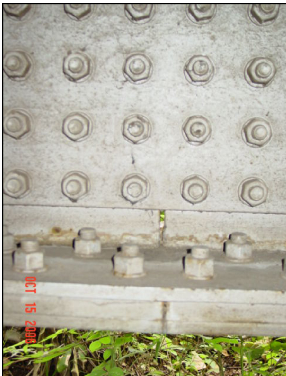
Unión de vigas
