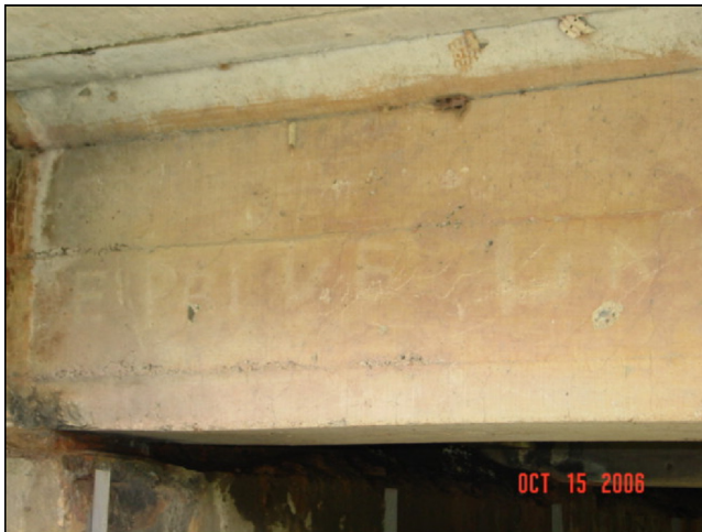
Estado de los apoyos
