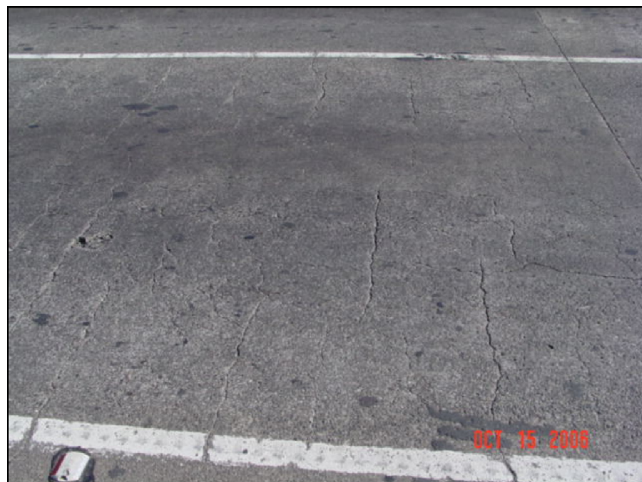
Estado de losa superior
