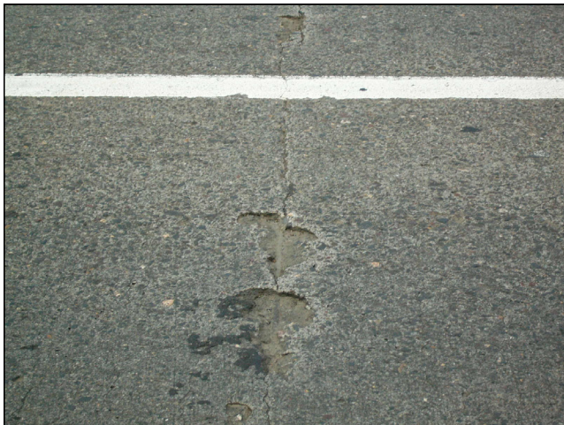
Estado de la losa superior
