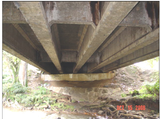
Vigas y diafragmas
