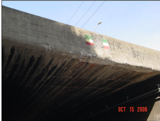
Estado de losa inferior
