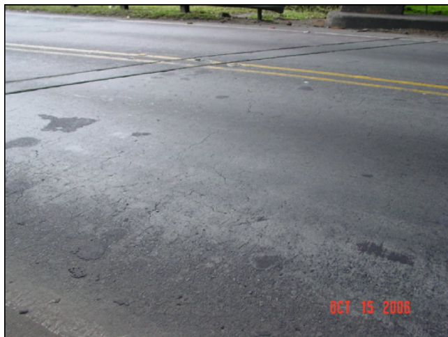
Estado de losa superior
