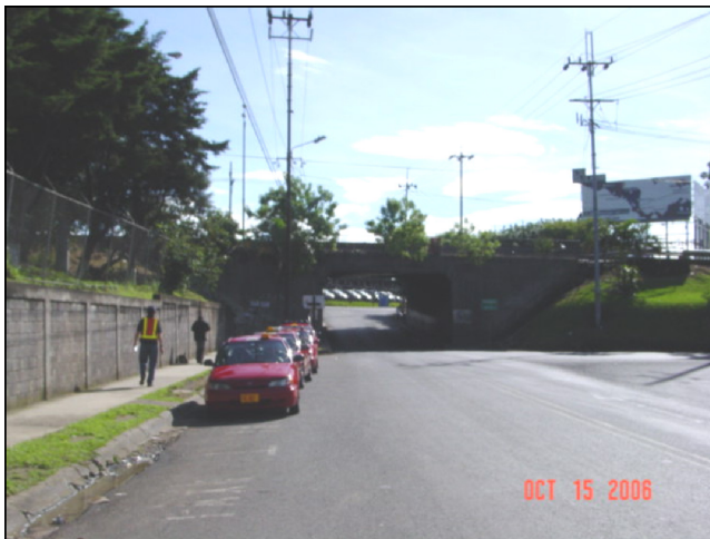
Puente Intersección Firestone
