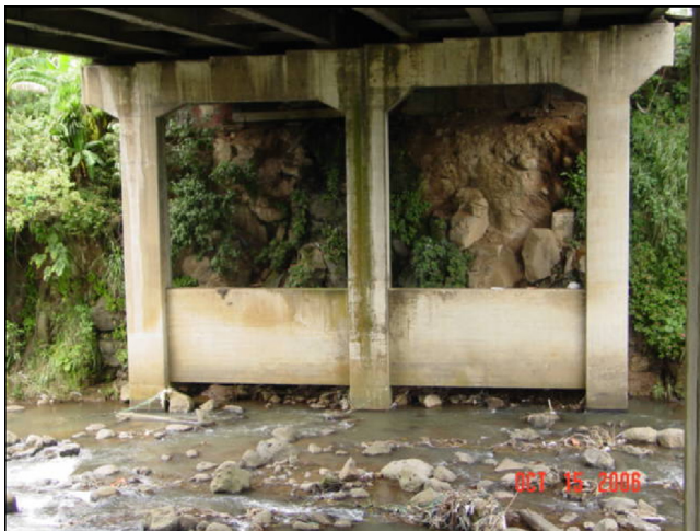
Estado de las pilas
