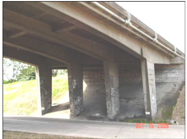
Unión vigas - pila
