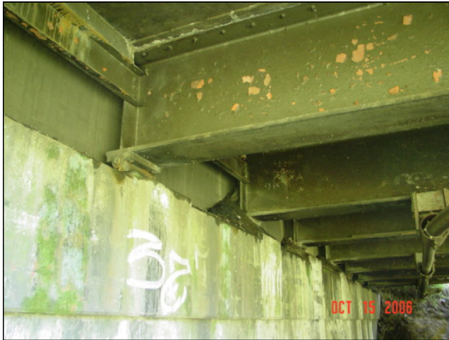
Vigas apoyadas en los bastiones
