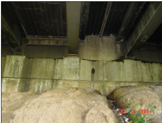
Estado del bastión
