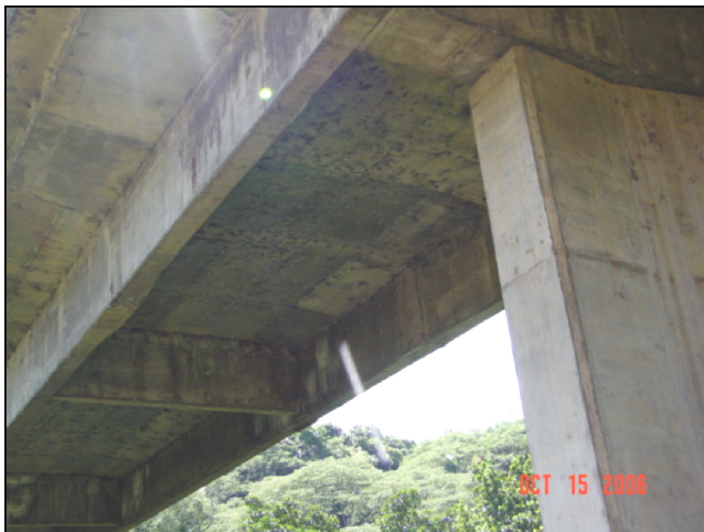
Estado de la subestructura
