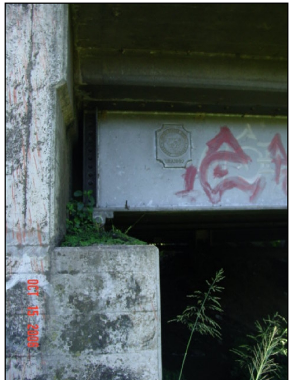
Apoyo en los bastiones
