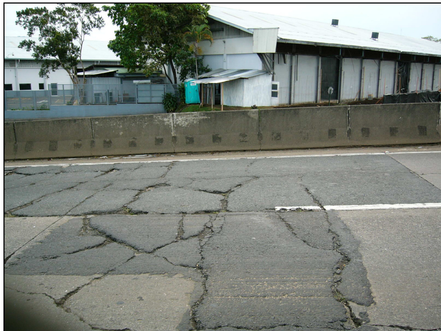
Estado de la losa de aproximación
