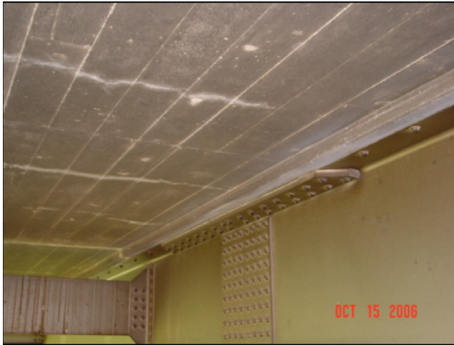
Conexión de vigas de acero
