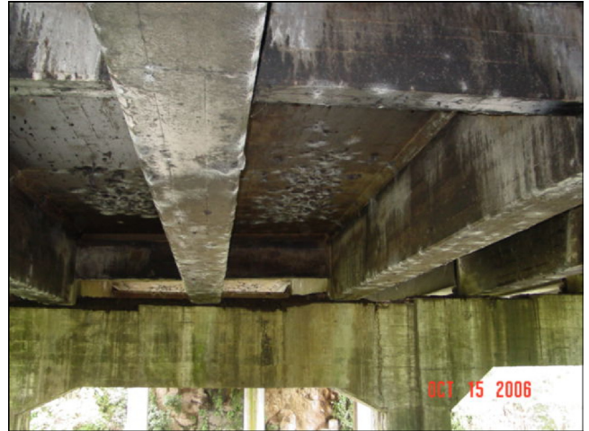
Unión viga - pila
