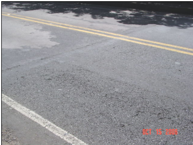
Estado losa superior
