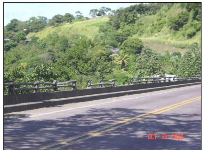
Estado de las barandas
