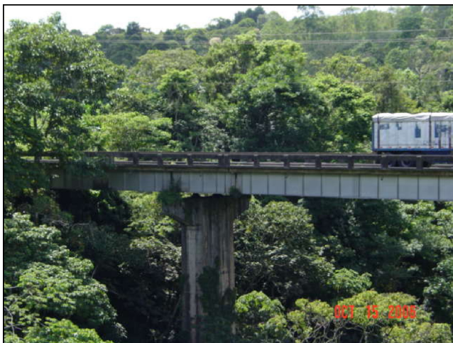
Puente Río Grande 2
