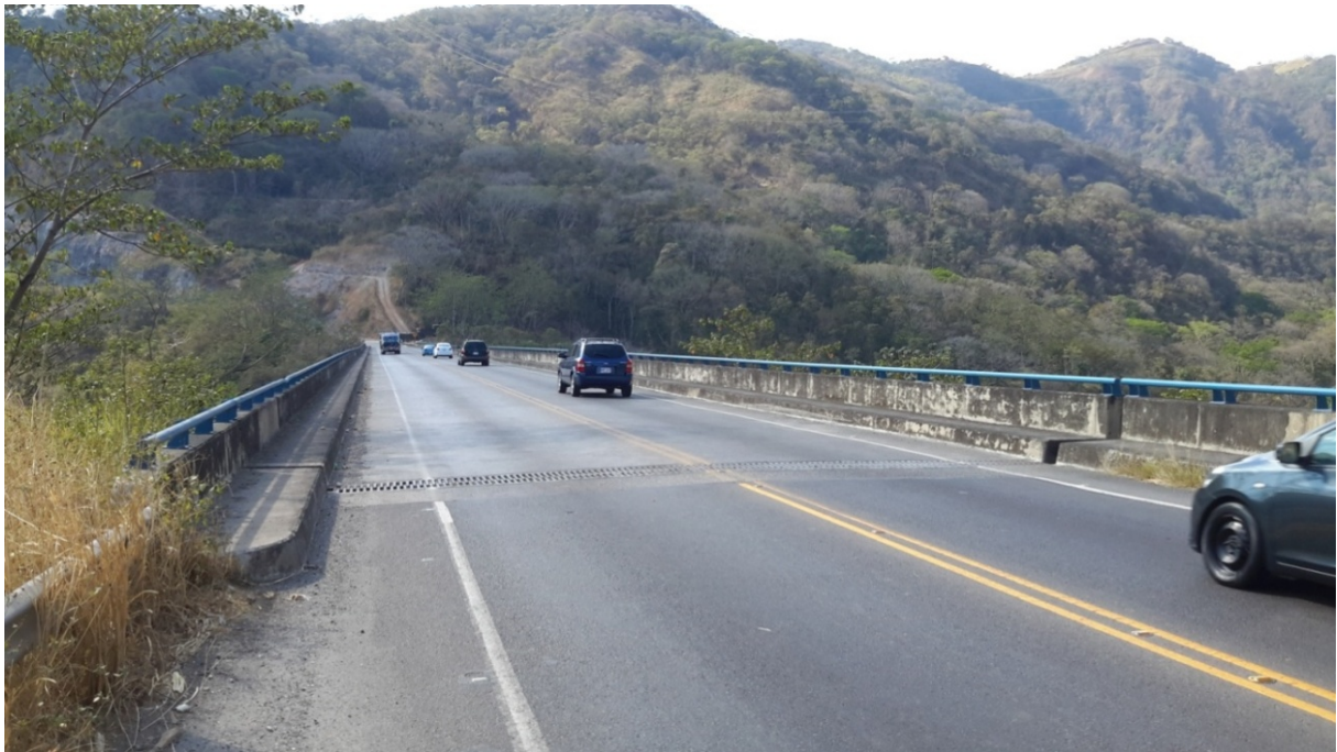
Figura 2. Vista a lo largo de la línea de centro del puente sobre el río Concepción
