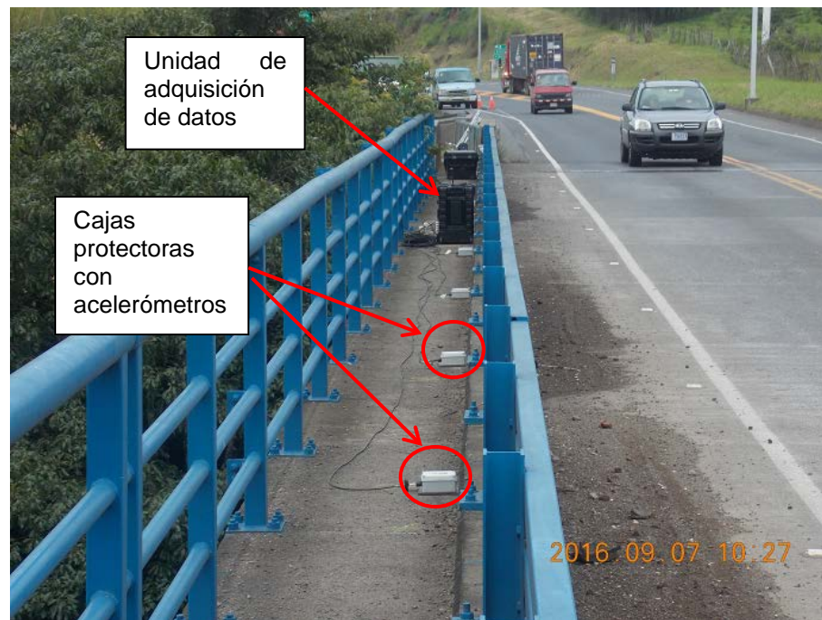
Figura B.2. Ejemplo de toma de datos sobre las aceras de un puente, nótese que no es necesaria la interrupción del tránsito vehicular
