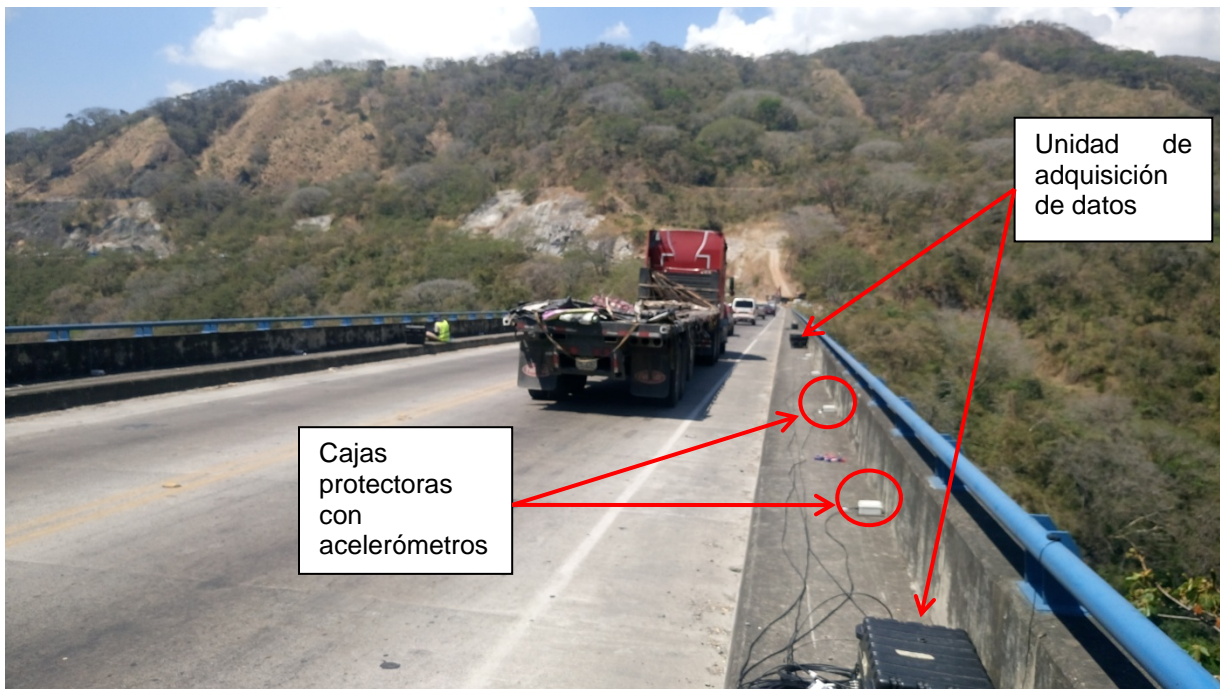
Figura 5. Colocación de sensores sobre las aceras del puente. Nótese que el monitoreo no interrumpe el tránsito de vehículos
