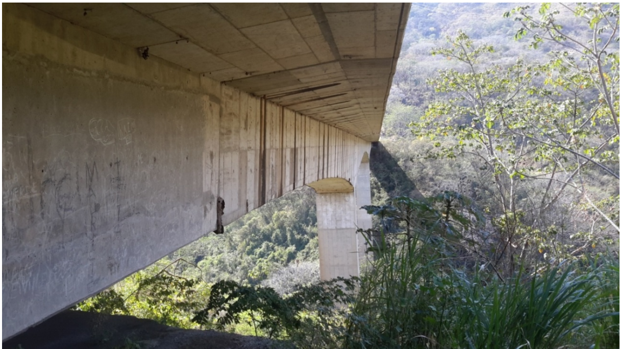
Figura 3. Vista lateral del puente sobre el río Concepción
