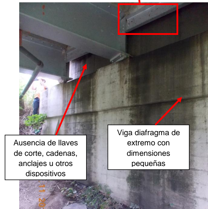
Figura 13. Ausencia de llaves de corte u otros dispositivos para prevención de colapso en caso de sismo. Vigas diafragma de los extremos con dimensiones pequeñas que pueden llevar a un mal comportamiento del puente ante un sismo.
