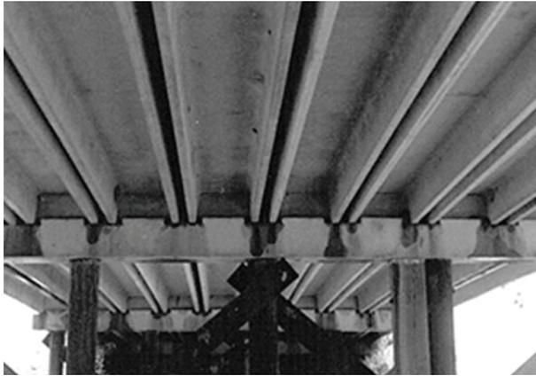
(c) Viga canaleta de concreto
