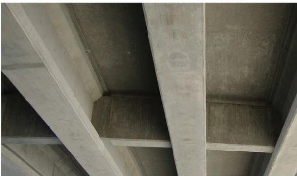
(a) Vigas diafragma de concreto conectando vigas principales de concreto
