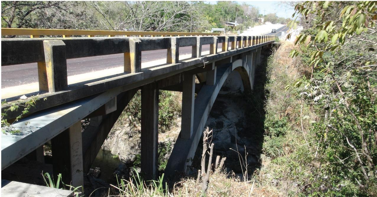
► **Figura 17.** Superestructura de arco de paso superior. Puente sobre el río El Salto RN1
