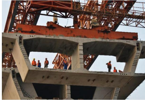
(d) Viga cajón de concreto
