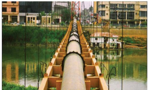
d) Puente para tuberías
