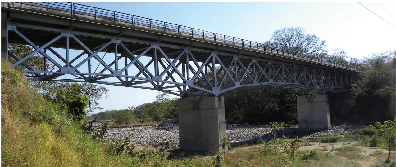
► **Figura 14.** Superestructura tipo cercha de paso superior. Puente sobre el río Aranjuez, RN1
