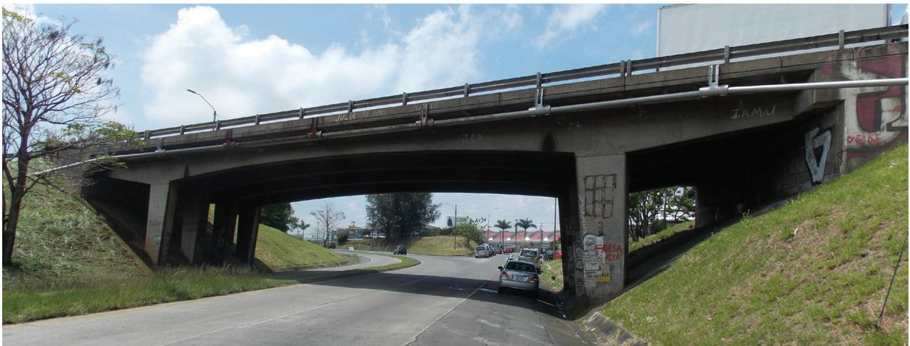
► Figura 12. Superestructura de marcos rígidos en el sentido longitudinal. Paso inferior intersección Alajuela RN1
