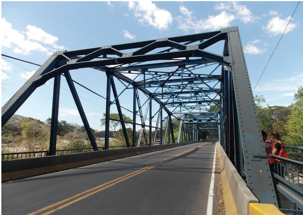
► **Figura 15.** Superestructura tipo cercha de paso inferior. Puente sobre el río Abangares, RN1
