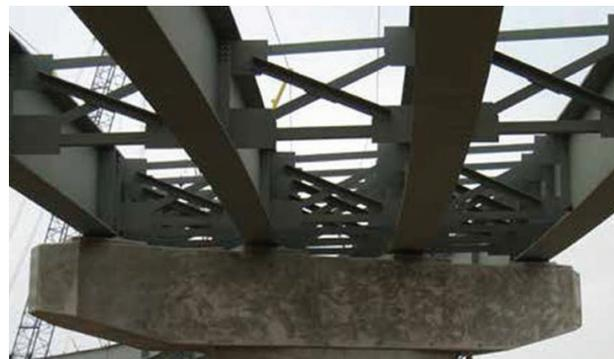
(b) Viga diafragma de armadura de acero conectando vigas principales de acero
