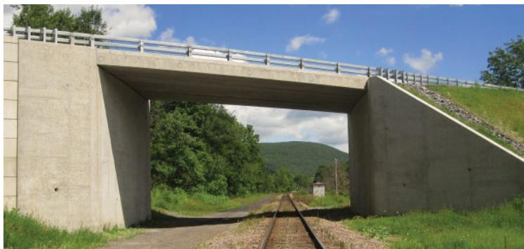
► Figura 5. Superestructura de losa de concreto
