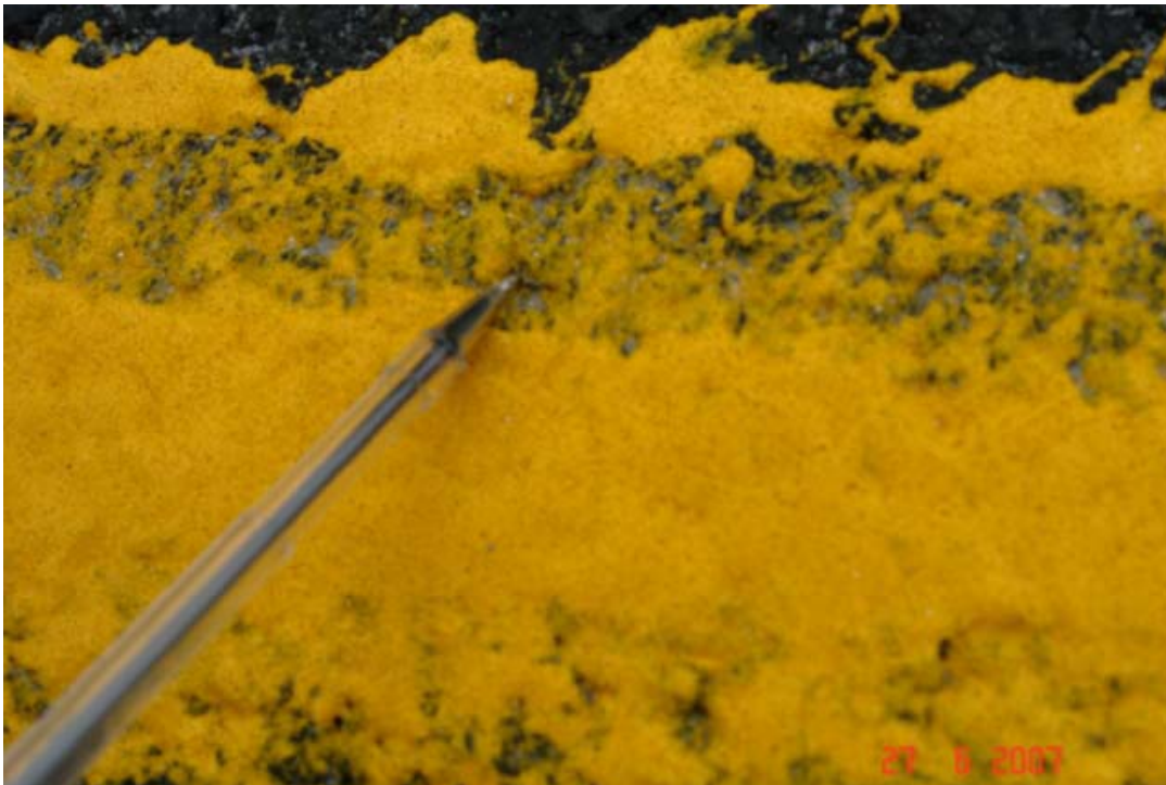
Fotografía 1. Demarcación realizada bajo la lluvia cerca del kilómetro 89, RN N°2.
