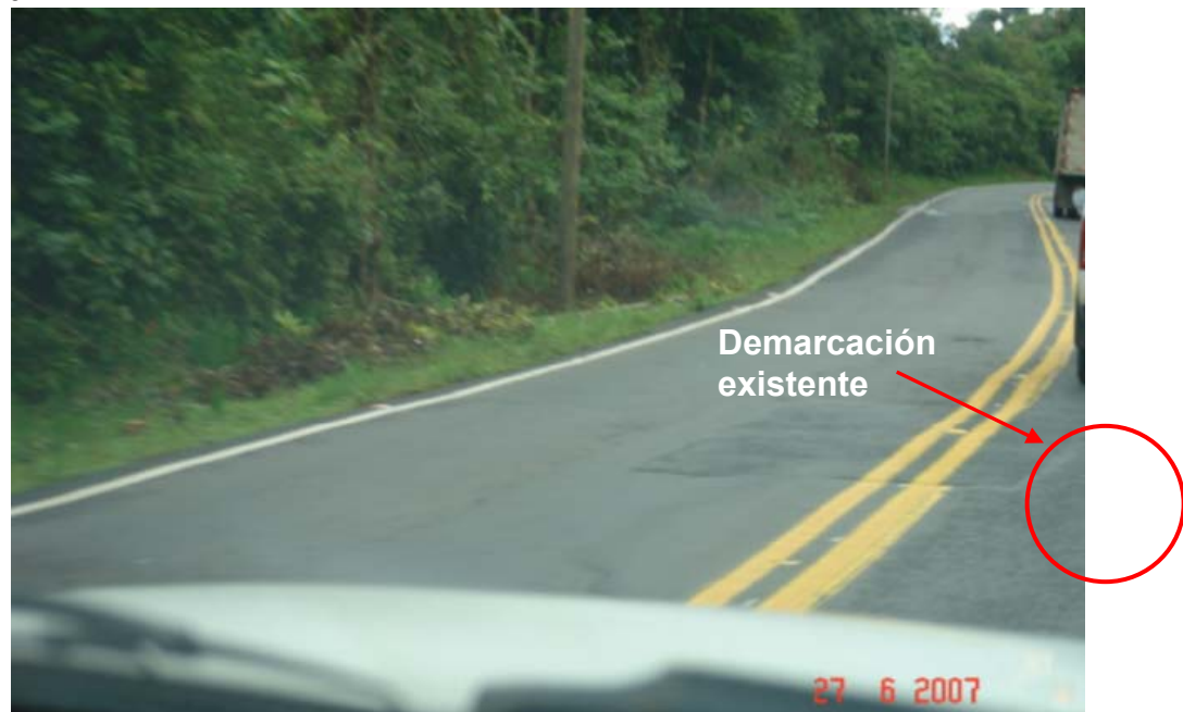
Fotografía 3. a. Demarcación realizada sobre pavimento deteriorado. b. Pintura colocada sobre demarcación existente
