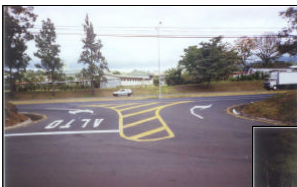
Fotografía 31 Radios de giro cortos intersección San Diego
