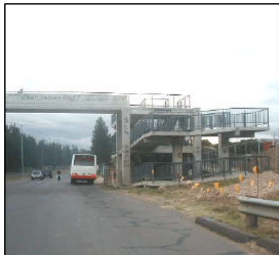
Fotografía 14 Columnas de puente peatonal
