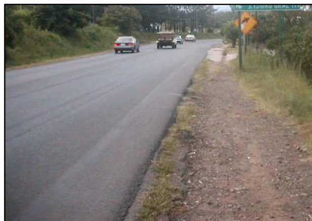
Fotografía 2 Espaldón inexistente
