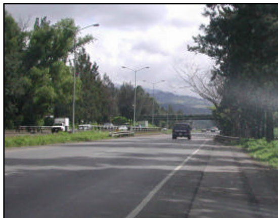
Fotografía 3 Inexistencia de espaldón en puentes sobre ríos y quebradas
