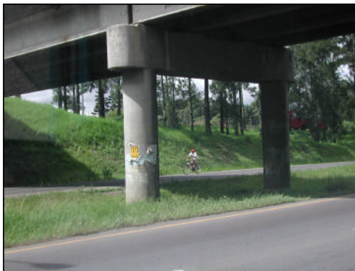
Fotografía 13 Columnas de puente vehicular
