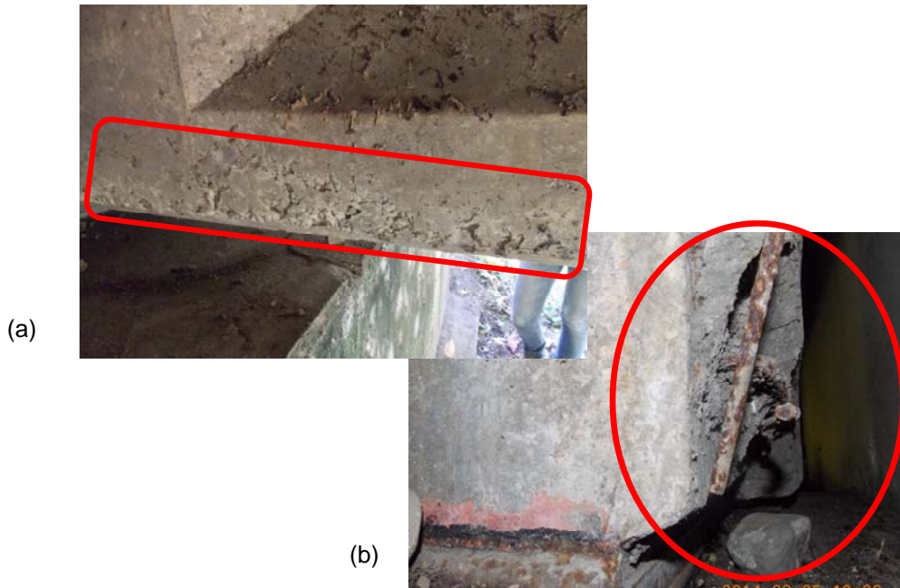
Figura 11. Vigas del extremo sureste del acceso 2: (a) Nidos de piedra superficiales; (b) Acero de refuerzo expuesto con estado avanzado de corrosión en parte posterior.
