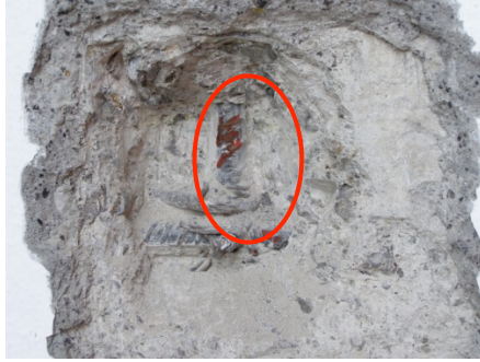
Varilla expuesta en la pica
